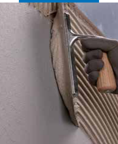
Montajul plăcilor ceramice cu Ultramastic III
