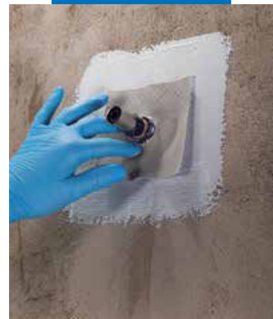
Aplicarea piesei speciale Mapeband PE 120 pentru tevi utilizând Mapegum WPS
