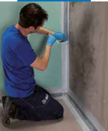
Aplicarea benzii Mapeband PE 120 folosind Mapegum WPS
