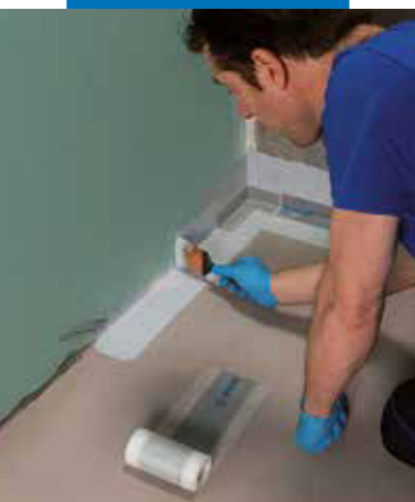
Aplicarea benzii Mapeband PE 120 folosind Mapegum WPS
